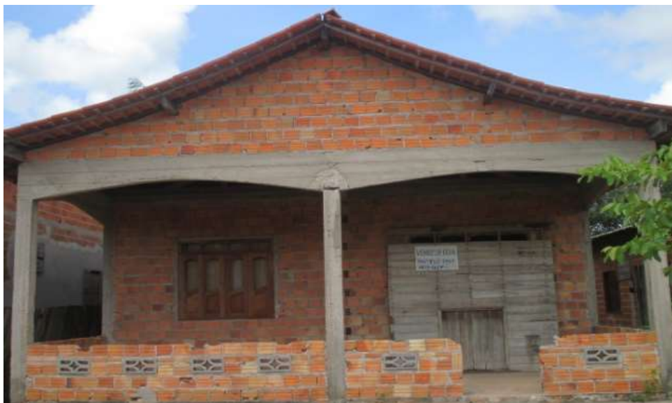
Figura 17: Casa em construção Fonte: Pesquisa de Campo
