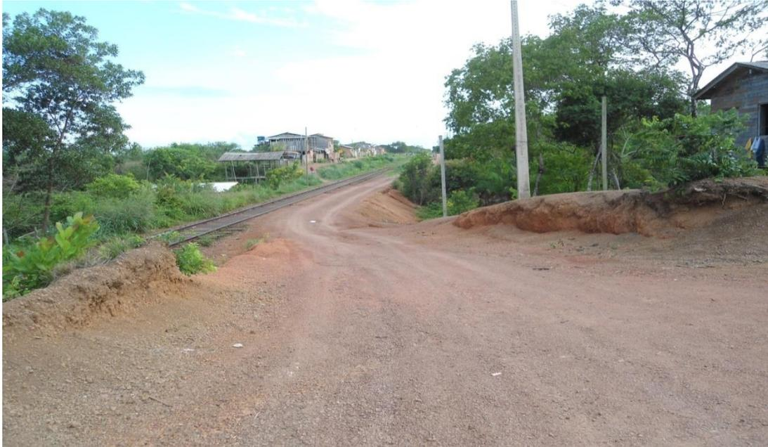
FOTO 08: Área de ressaca que foi aterrada para dá passagem a ferrovia
