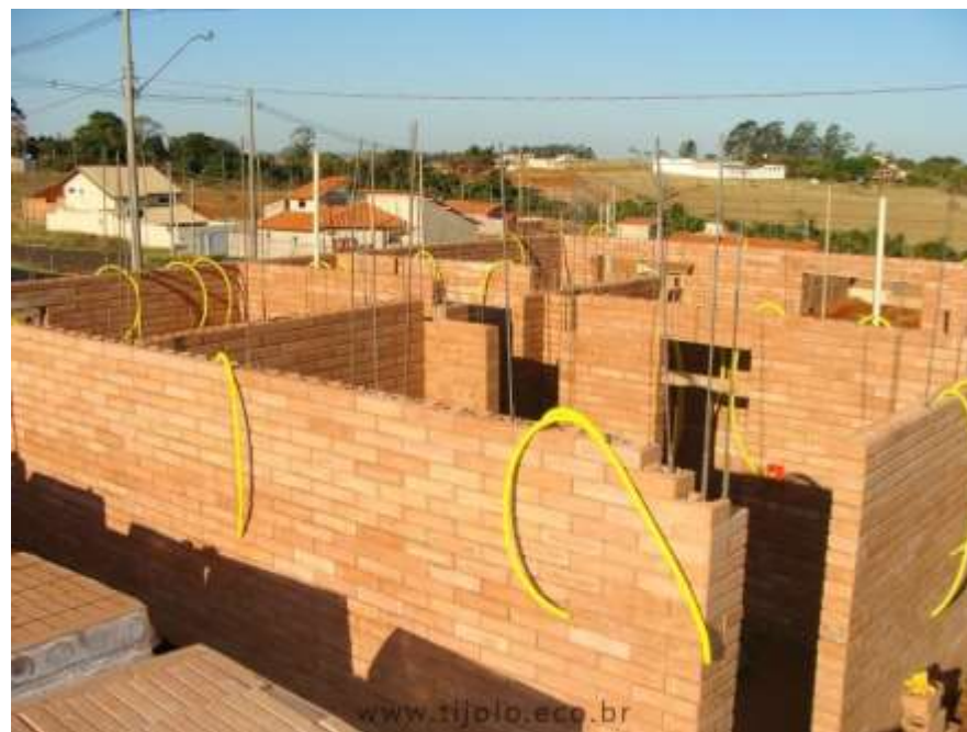
FIG. 06 Construção feita com ecotijolos Fonte: http://www.tijolo.eco.br/tijolo-ecologico/manual-de-projeto
