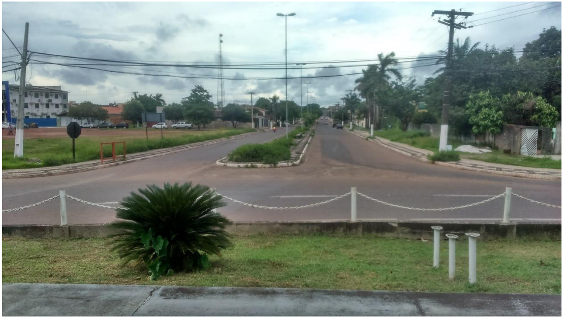
Fonte: Relatório fotográfico - SEINF
