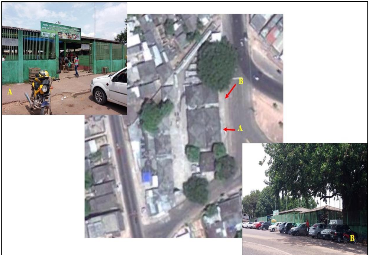
Figura 39 - Fachada e acesso principal de pedestres.
