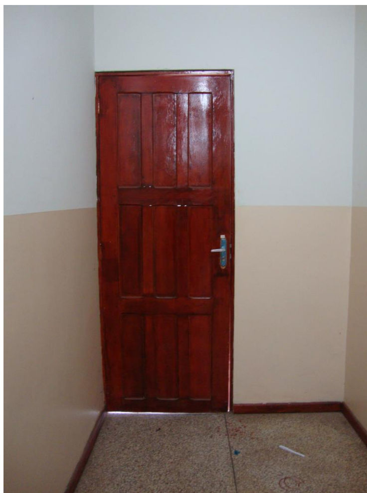
Figura 47 – Saída de Emergência
