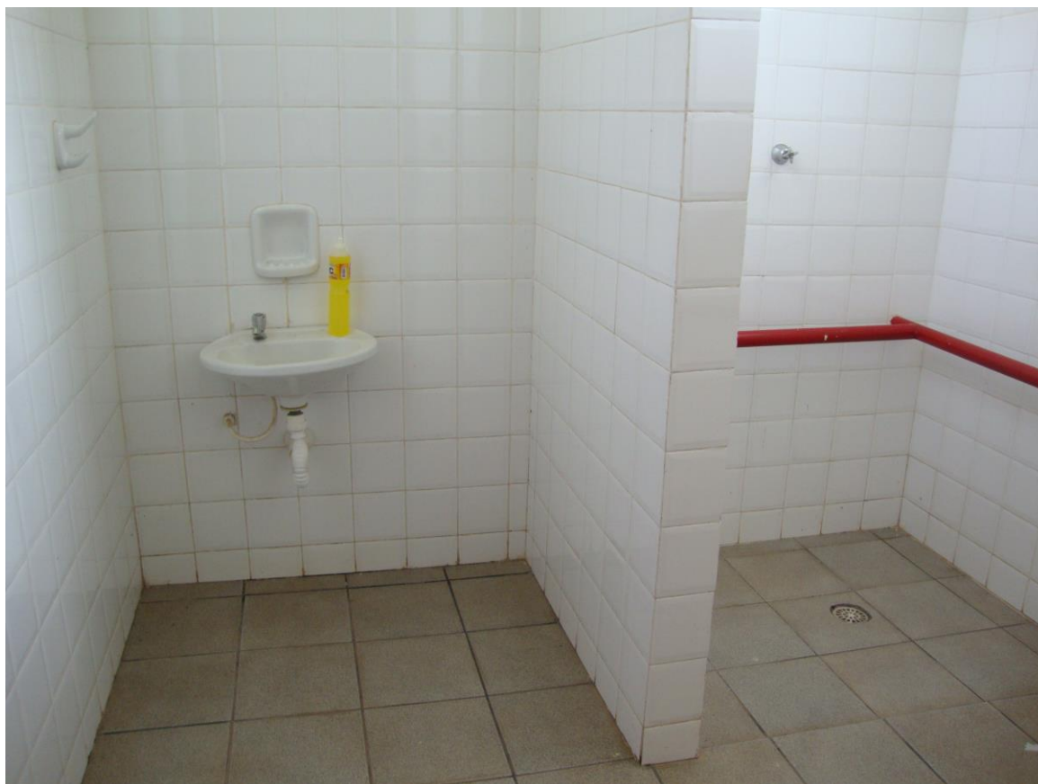
Figura 51 – Banheiro Adaptado - Lavatório
