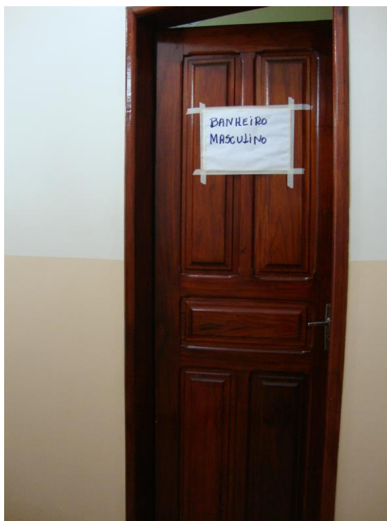
Figura 46 – Porta do Sanitário Masculino
