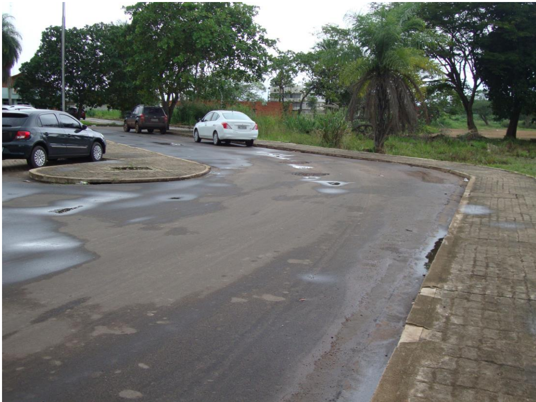
Figura 55 – Calçada de acesso ao Estacionamento
