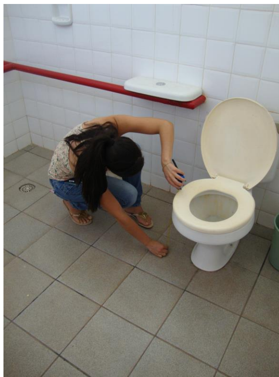
Figura 45 – Medição dos Sanitários do CREMSA
