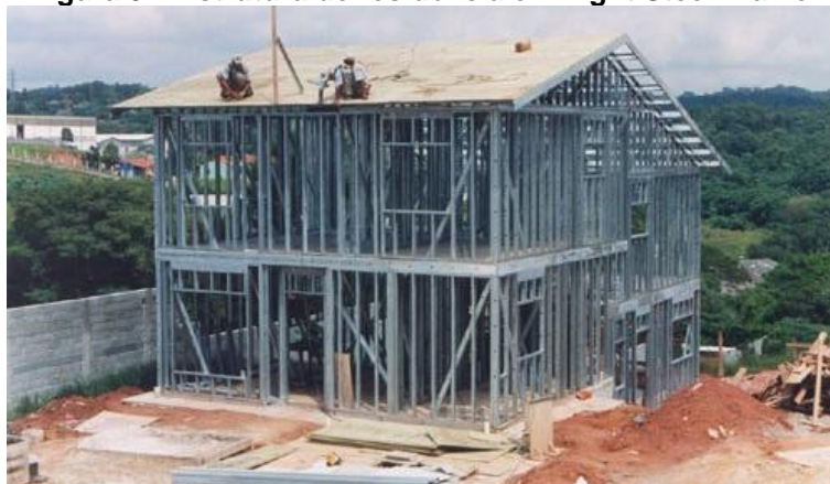
Figura 9 – Estrutura de residência em Light Steel Frame.
