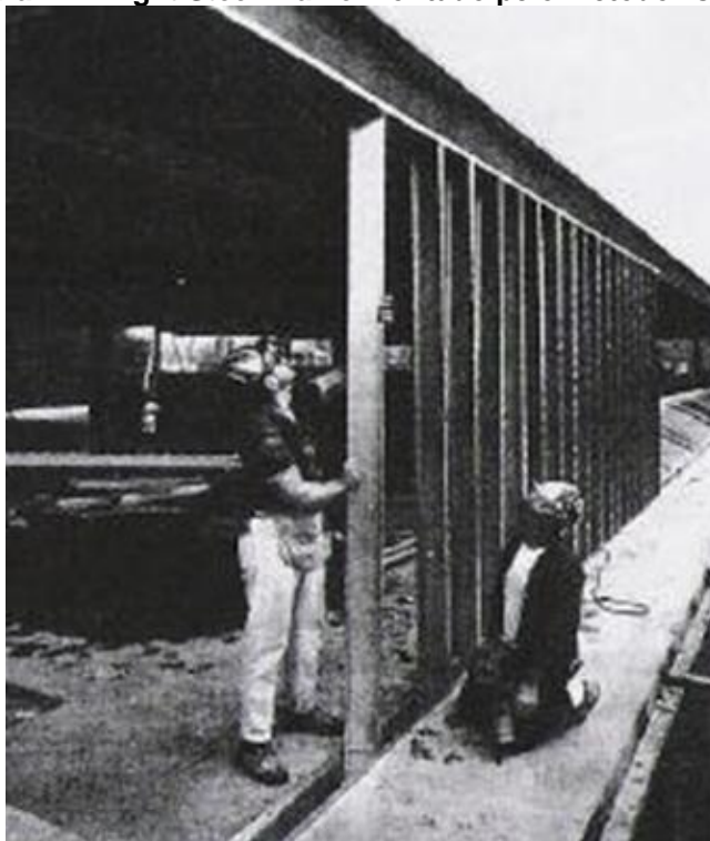
Figura 11 – Light Steel Frame montado pelo método “stick”.
