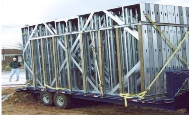
Figura 12 – Elementos estruturais como tesouras.
