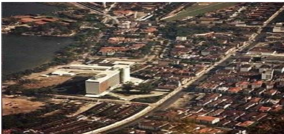
Figura 29: Vista panorâmica da implantação do Hospital Sul América recém-construído Fonte: Alves (2010)
