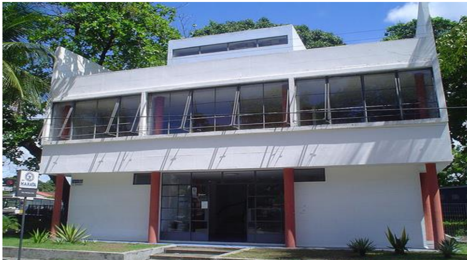
Figura 28: Pavilhão de Óbitos da Faculdade de Medicina, atual Instituto de Arquitetos do Brasil (IAB). Fonte: Alves (2010)
