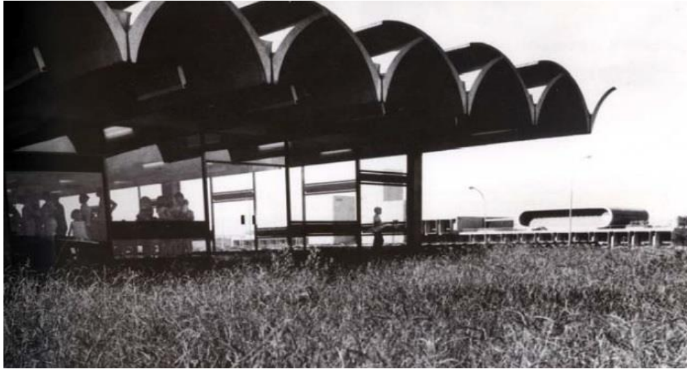
Figura 31: Hospital Distrital de Taguatinga Fonte: MIQUELIM (1998)
