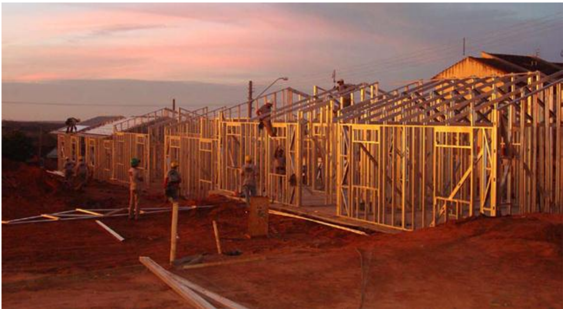
Figura 05: Execução de habitações com tecnologia steel frame Fonte: www.cbca-acobrasil.org.br
