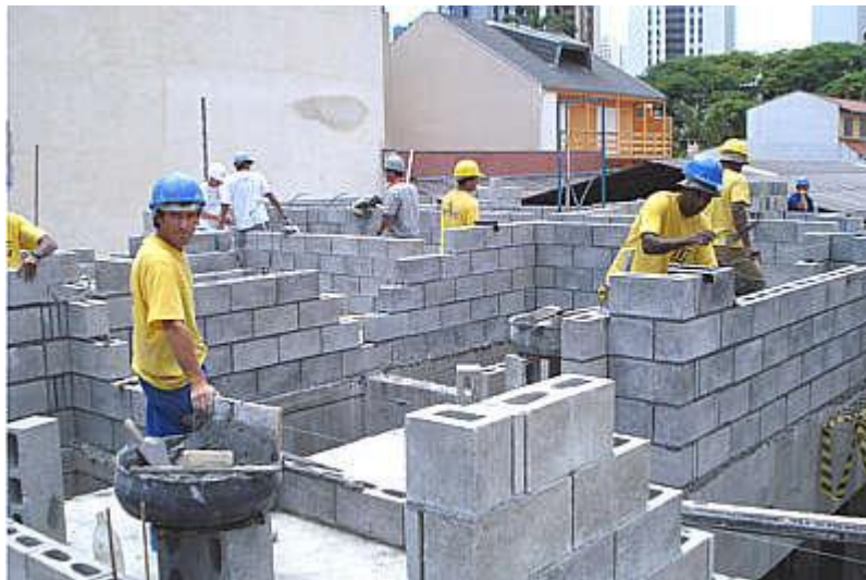
Figura 02: Execução de habitações com bloco estrutural. Fonte: www.construcaomercado.pini.com.br .
