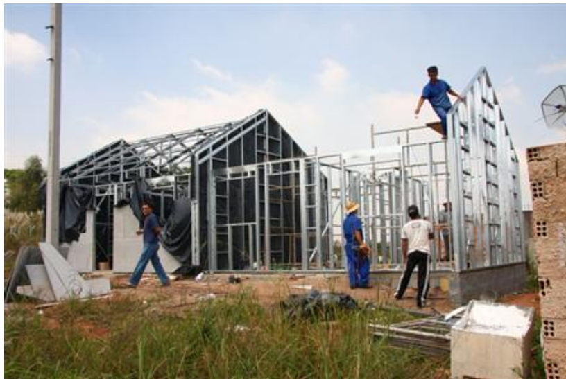
Figura 06: Execução de habitações com tecnologia steel frame. Fonte: www.cohabct.com.br
