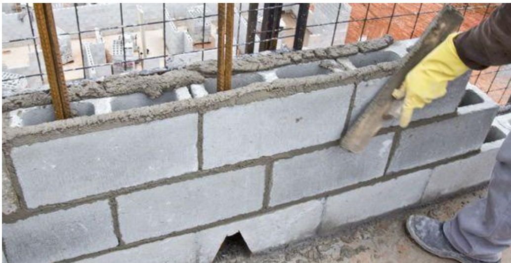
Figura 01: Assentamentos de blocos estruturais. Fonte: www.construcaomercado.pini.com.br .
