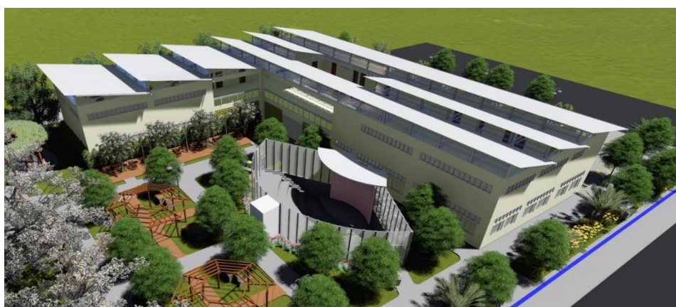
Figura 118 – Cobertura com sistema shed - Biblioteca Pública Municipal de Macapá.
