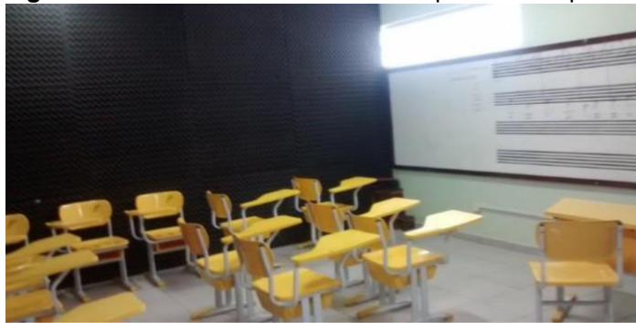
Figura 10 – Sala com revestimento adaptado em espuma
