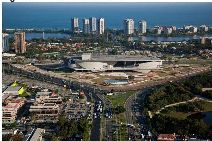
Figura 01 – Visão aérea da obra
