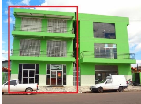
Figura 08 – Prédio alugado de atual funcionamento
