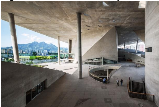
Figura 05 – Estrutura da edificação
