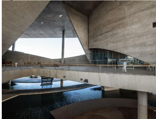
Figura 04 – Estrutura da edificação
