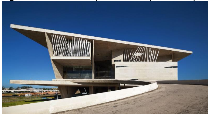
Figura 03 – Uma das rampas de acesso para edificação
