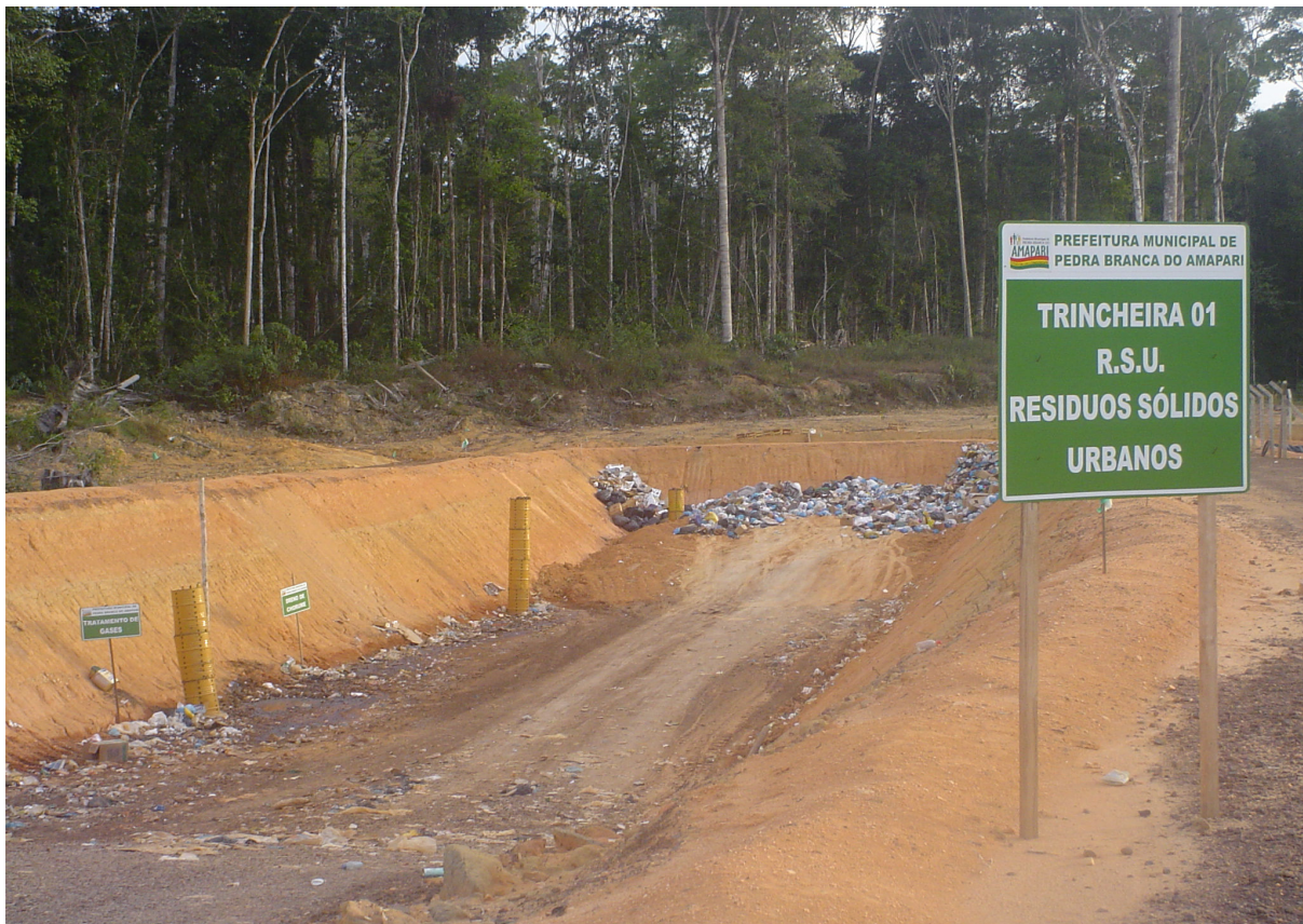
Figura 41 – Detalhe da trincheira de resíduos sólidos urbanos na Central de Tratamento de Resíduos Sólidos de Pedra Branca do Amapari.
