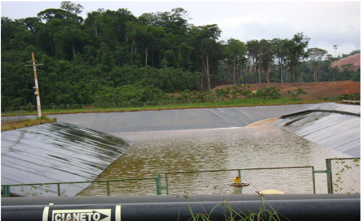
Figura 27 – Mostra detalhe da bacia de decantação de resíduos da MPBA.
