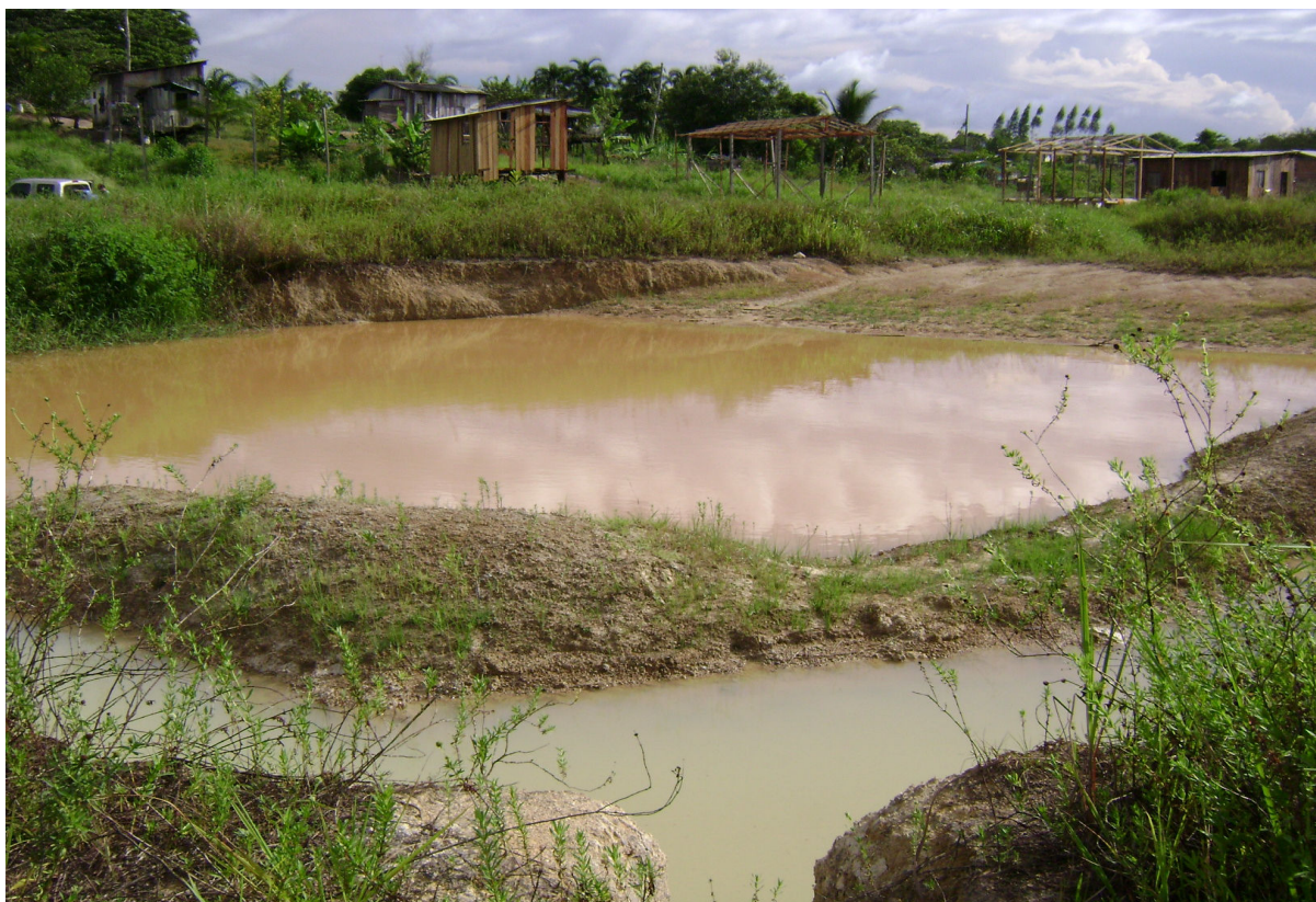
Figura 32 – Impacto causado pela retirada de argila para a Olaria da Prefeitura de Pedra Branca do Amapari no perímetro urbano da cidade.
