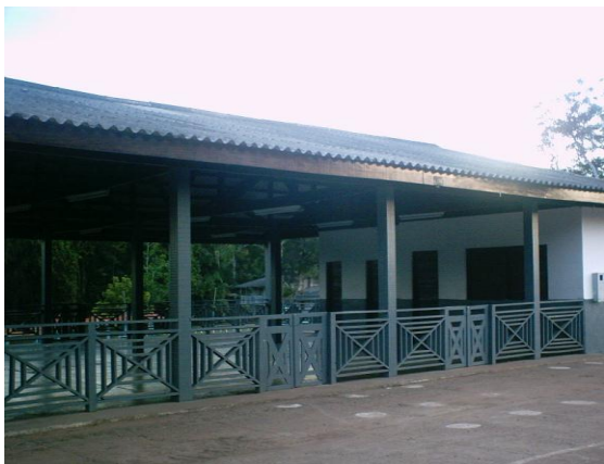
Figura 07: Sede Barracão de São Tiago. Fonte: Pesquisa de campo realizada em agosto de 2010.
