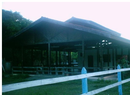
Figura 06: Centro Comunitário de Mazagão Velho. Fonte: Pesquisa de campo realizada em agosto de 2010.
