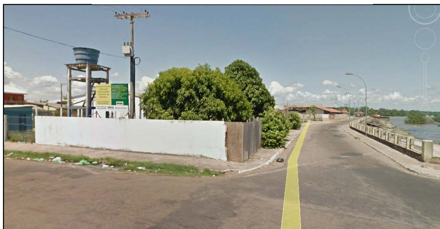
Figura 31 Local da Obra da UBS Cidade Nova
