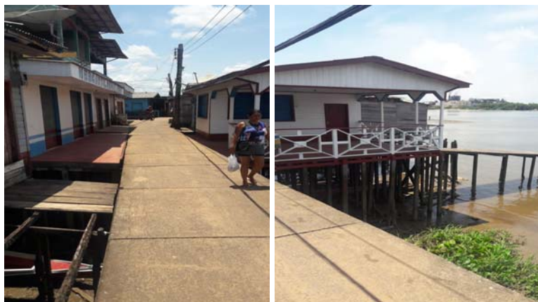
Figura 48- Comercio a esquerda construído em alvenaria sobre estacas as margens do rio Jari
