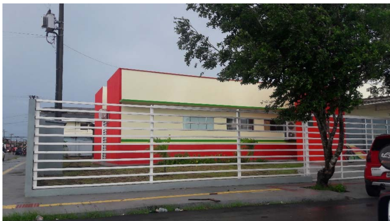
Figura 36 - Fachada da UBS Cidade Nova já concluída
