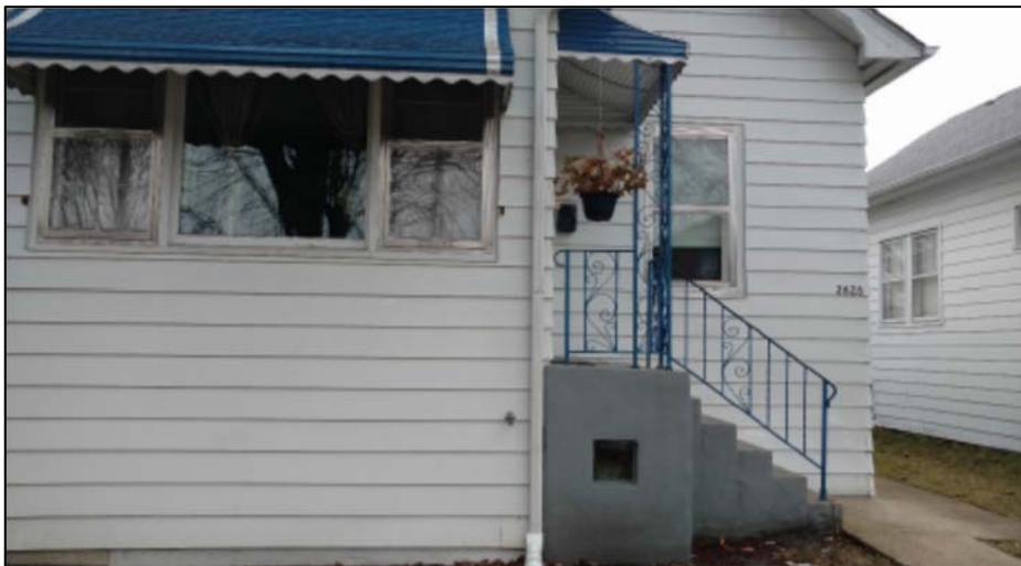
Figura 19- Casa com mais de 100 anos, construída no padrão Wood Frame
