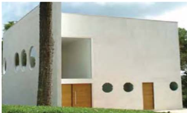
Figura 27 - Fachada exterior com acabamento com estuque
