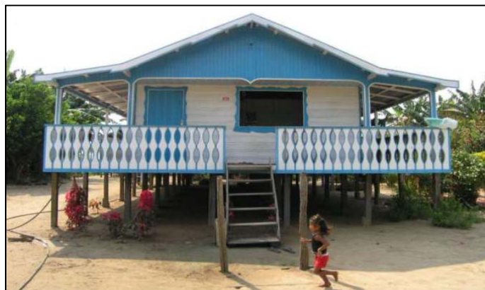
Figura 6- Casa ribeirinha com a varanda coberta
