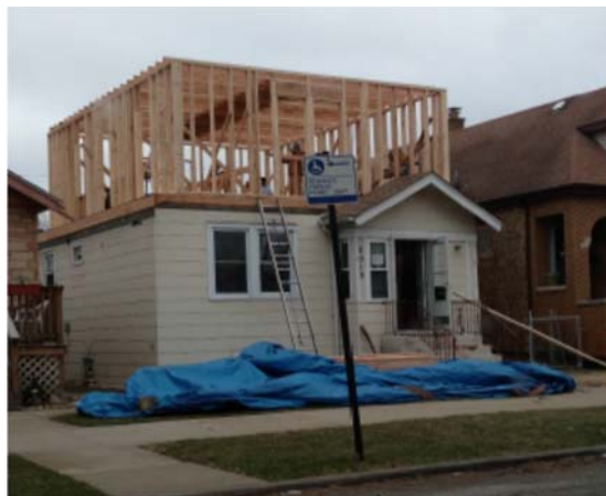
Figura 26 Construção de casa utilizando acabamento em Vinyl Siding
