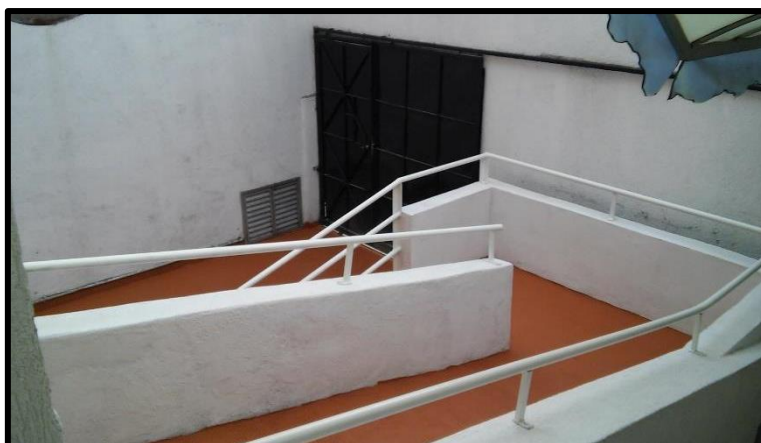
Figura 18: Rampa de acesso
