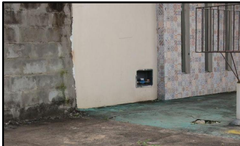
Figura 35: Registro de abastecimento de água.
