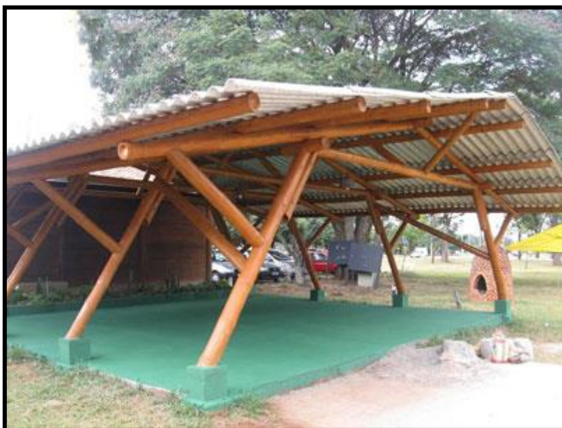
Figura 60: Estrutura feita com bambu
