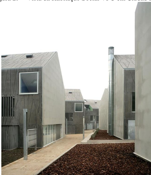
Figura 29 – Vista da Habitação Social VPO em Ciudad Real
