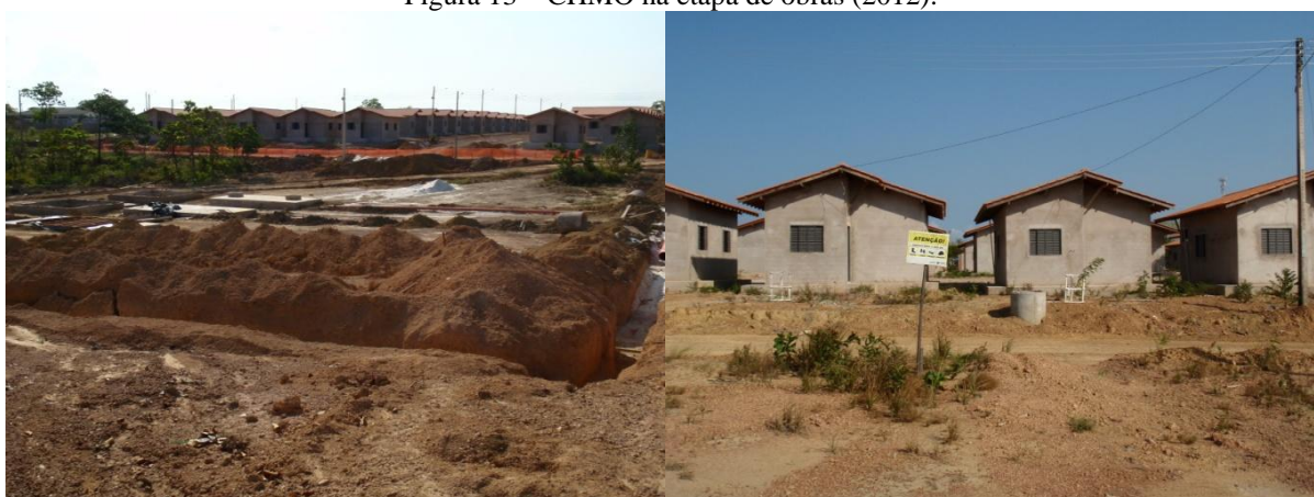
Figura 13 – CHMO na etapa de obras (2012).
