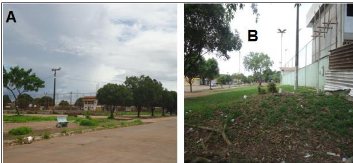
Figura 40 - (A) Ausência de usuários (B) Aspecto de abandono, observação na fachada leste, sentido Norte/Sul
