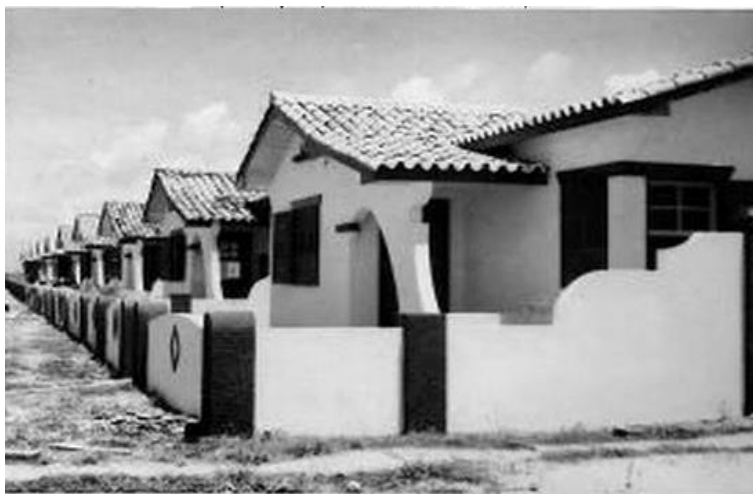
Fotografia 1 - Anos 40 – Casa para funcionários do antigo Território do Amapá, construída na avenida Presidente Vargas, centro de Macapá
