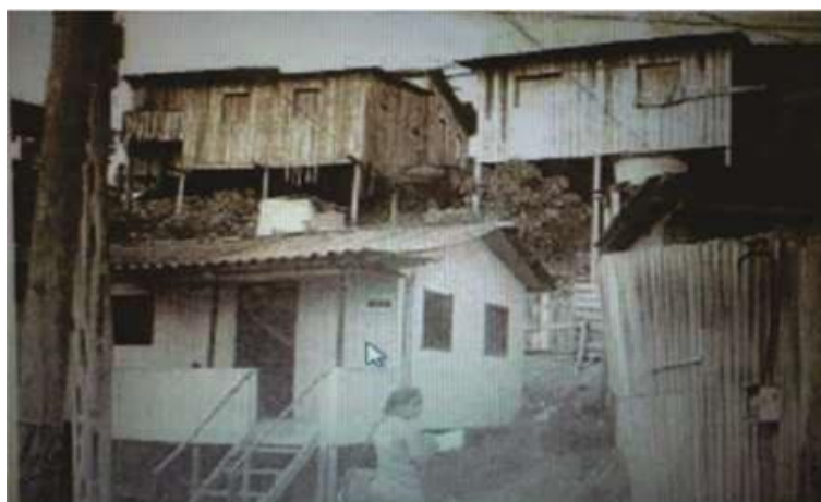
Fotografia 5 - Vila Mucajá sofre perigo de desabamento
