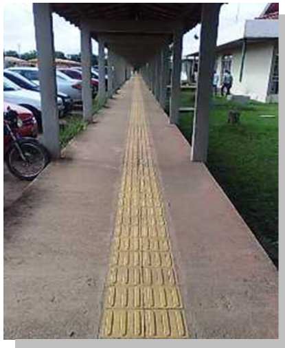
Figura 1- Piso Tátil da passarela central da UNIFAP
