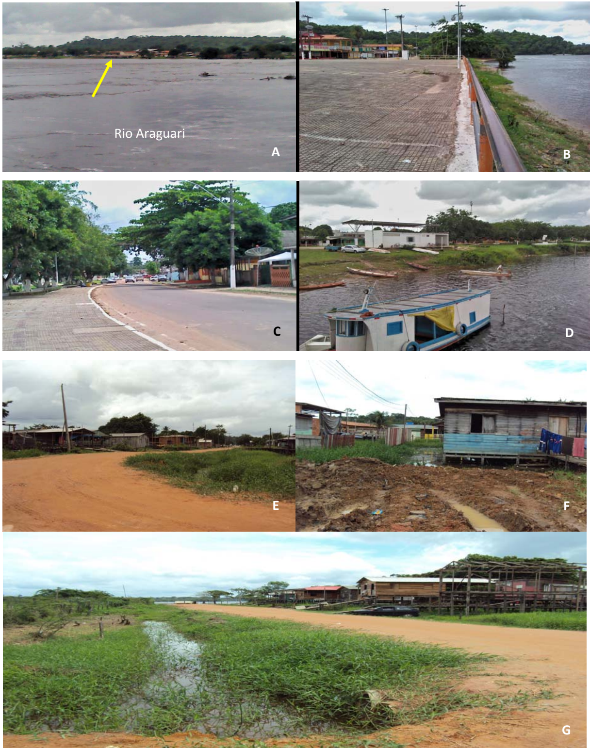
Figura 14 - Fotos mostrando a localização do município de Ferreira Gomes (seta) às margens do rio Araguari (A) e a infraestrutura da cidade (B, C, D, E e F). Na figura G nota-se a presença de esgoto a céu aberto que desemboca diretamente no rio Araguari.
