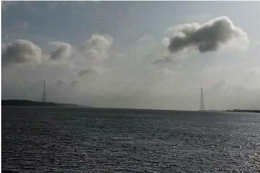
Fotografia 7 - Torres do Linhão de Tucuruí, próximo ao município de Almeirim-PA em 2018.
