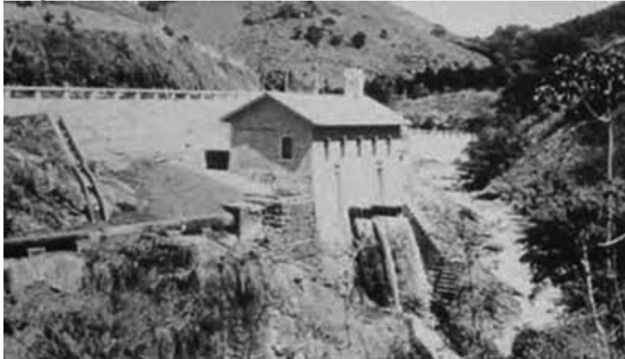
Fotografia 1 - Usina hidrelétrica Ribeirão do Inferno (1883), em Diamantina, MG.
