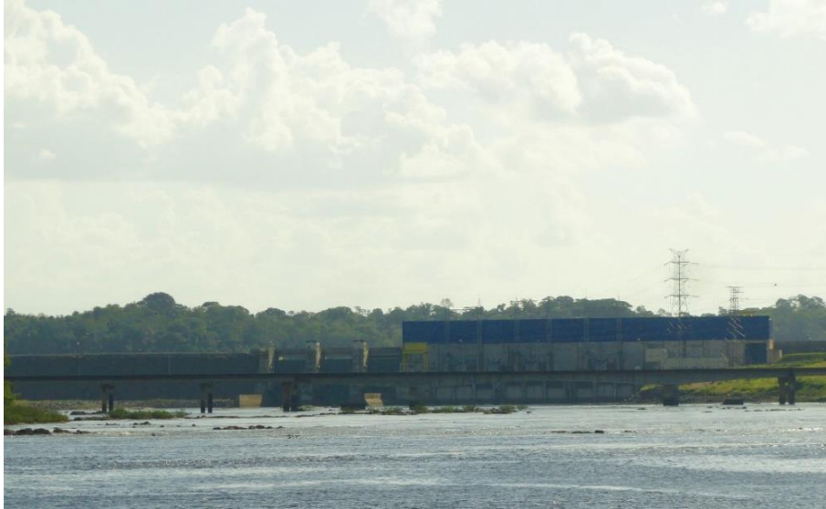
Fotografia 10 - UHE Ferreira Gomes ao lado da ponte Tancredo Neves (BR-156) em 2017.
