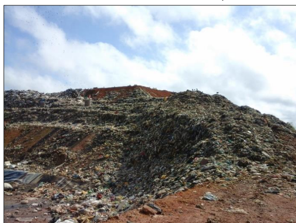
Figura 22 – RSU dispostos de forma inadequada no aterro semi-controlado de Macapá.
