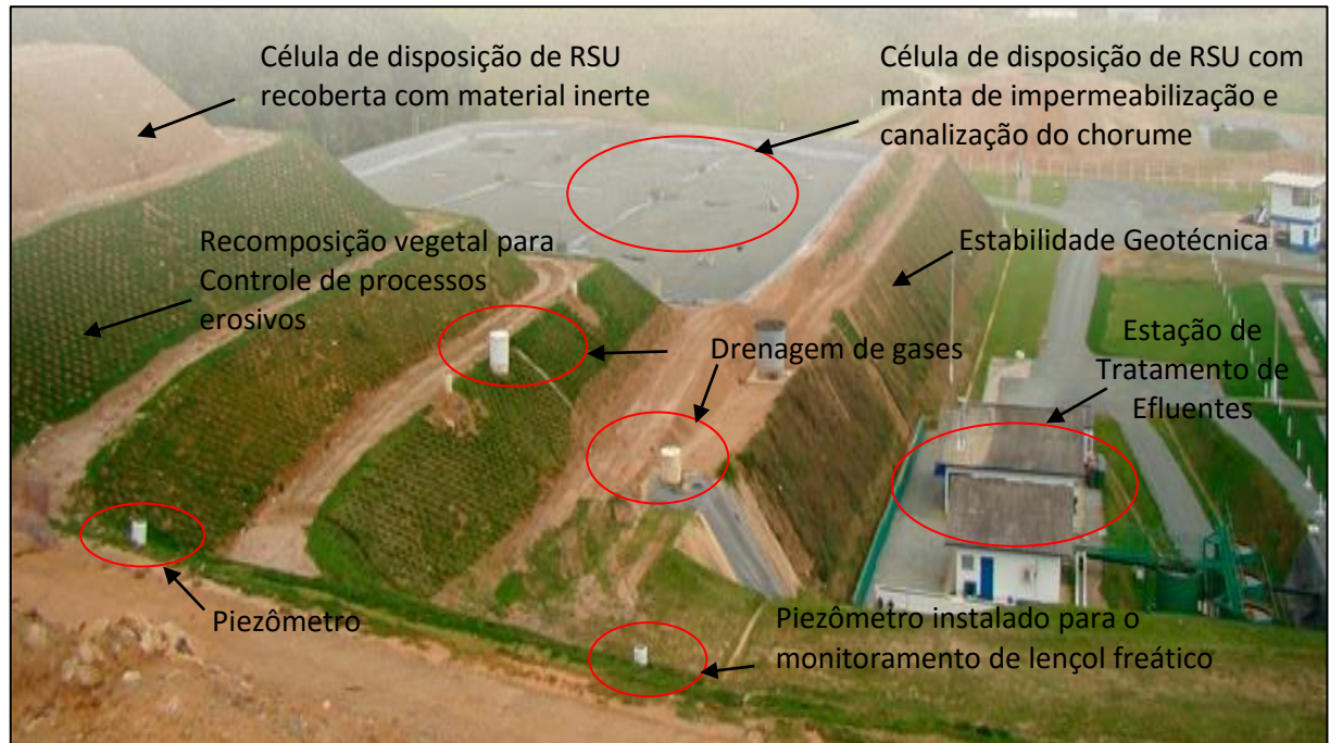
Figura 9 - Modelo de aterro sanitário construído no município de Itajaí-SC, em conformidade com as normas técnicas vigentes. Destaque para as estruturas existentes que orientam a sua construção e operação adequada.
