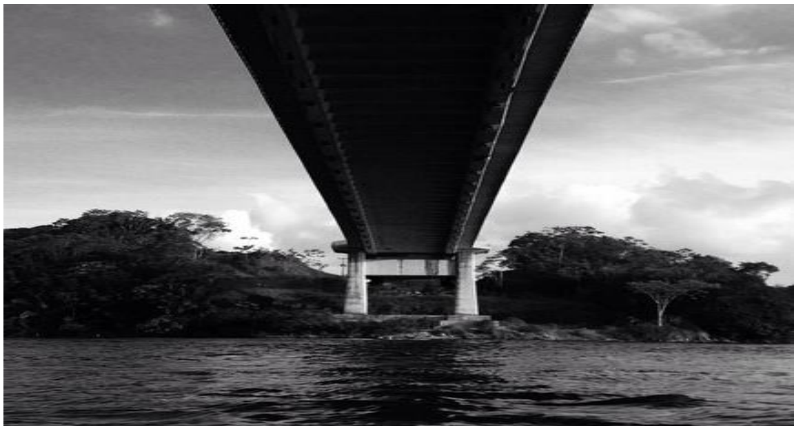
Imagem 1- Ponte binacional sobre o Rio Oiapoque
