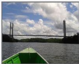
•Foto 15: Ponte Binacional
