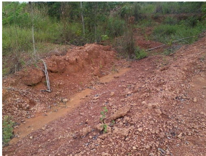
Figura 6 – Foto ilustrativa de processos erosivos
