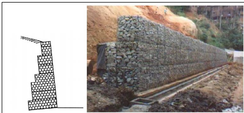
Figura 3 - Exemplo de aplicação de um muro de gabião.
