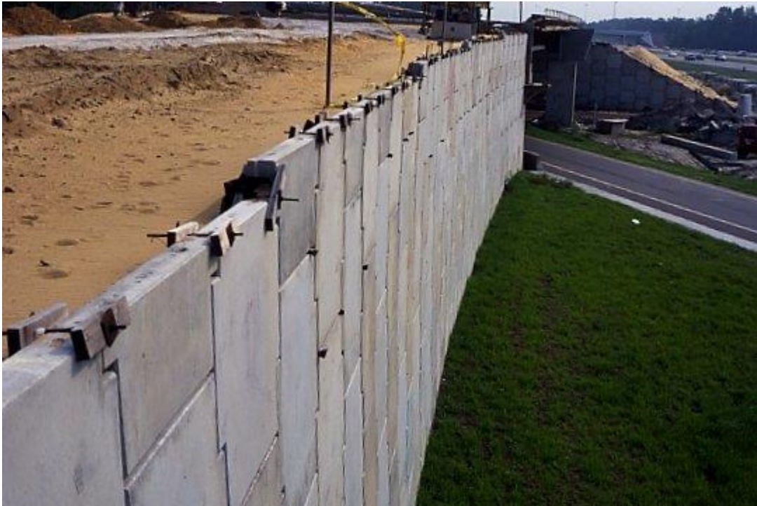
Figura 5 - Muro de Terra Armada
