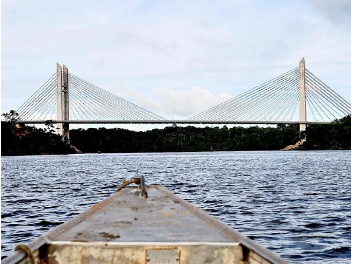
Figura 6: Ponte sobre o Rio Oiapoque. Fonte: Diário do Amapá.
