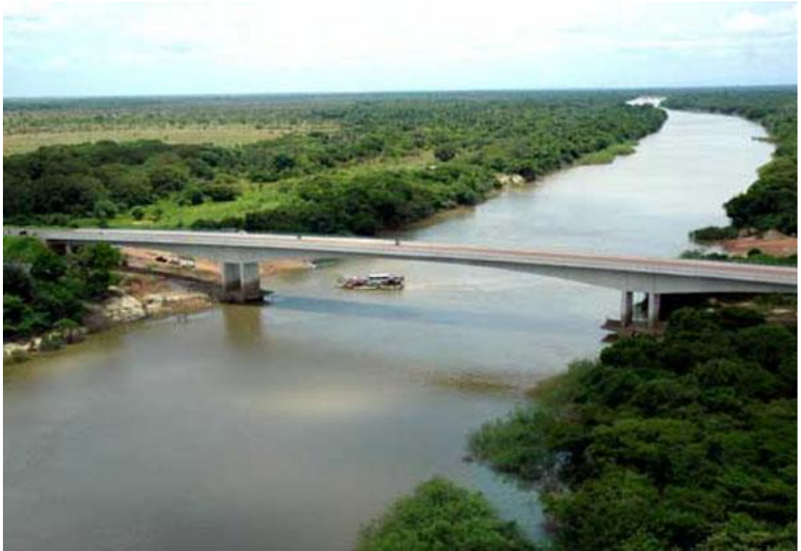
Figura 5: Ponte sobre o Rio Tacutú.
